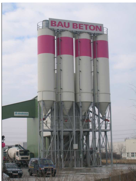
Bau Beton Ges.mbH, Werk Simmering
