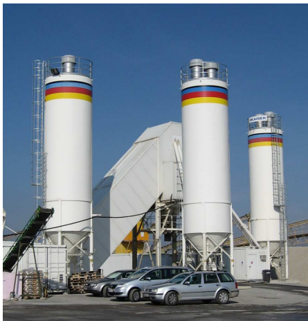
Wopfinger Transportbeton Ges.mbH, Werk Grafenwörth
