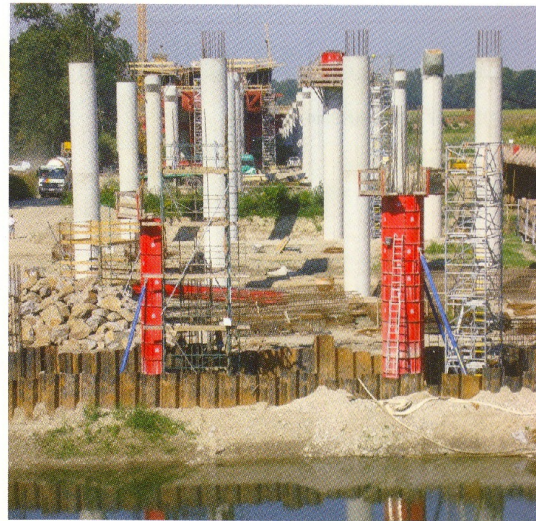
Vorlandbrückenpfeiler Süd C35/45/B4
