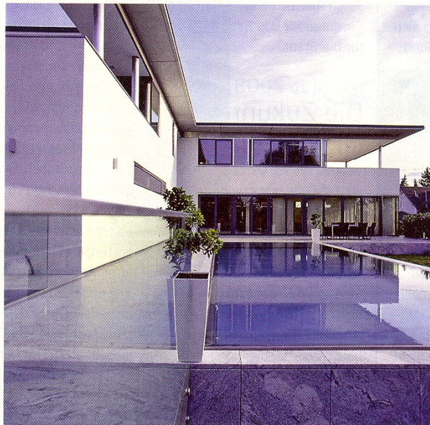
Die Anwendung von Erdsonden und Wärmepumpe in Verbindung mit Bauteiltemperierung schafft neue Möglichkeiten für Behaglichkeit auch im Wohnhausbau
